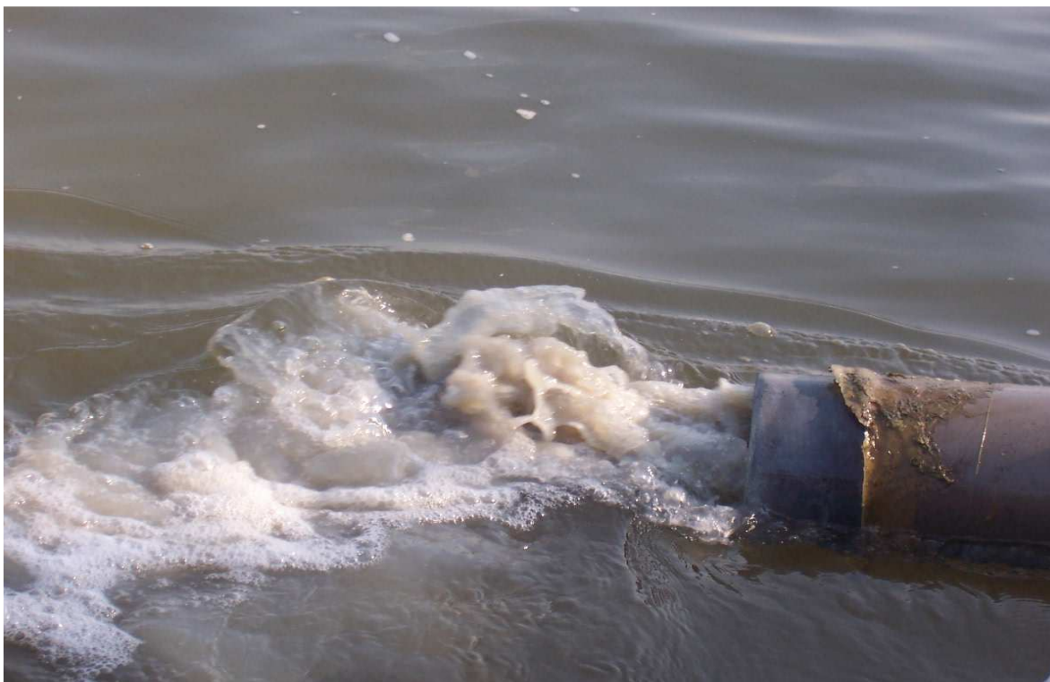
Figura12 - Sítio 1 – Manilha que leva os efluentes do curtume de couro para fundo do rio quebrado (29/08/2004).
