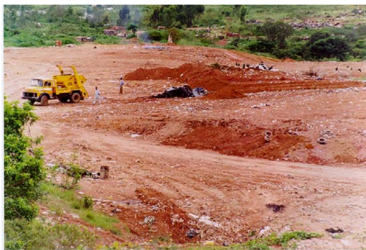
Figura 13 – Aterro sanitário - Patos de Minas (MG)
