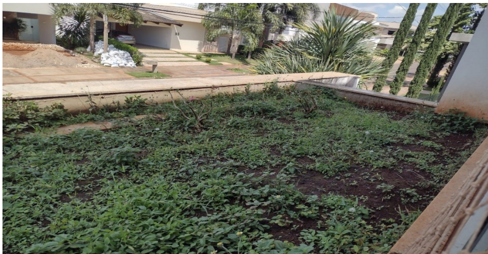
Figura 9 - Jardim sobre laje.
