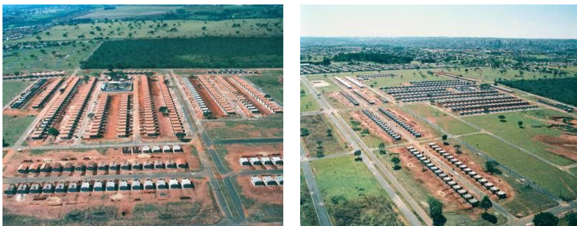
Figura 4.3 – Vista aérea do empreendimento completo – Vistas Oeste e Sul
