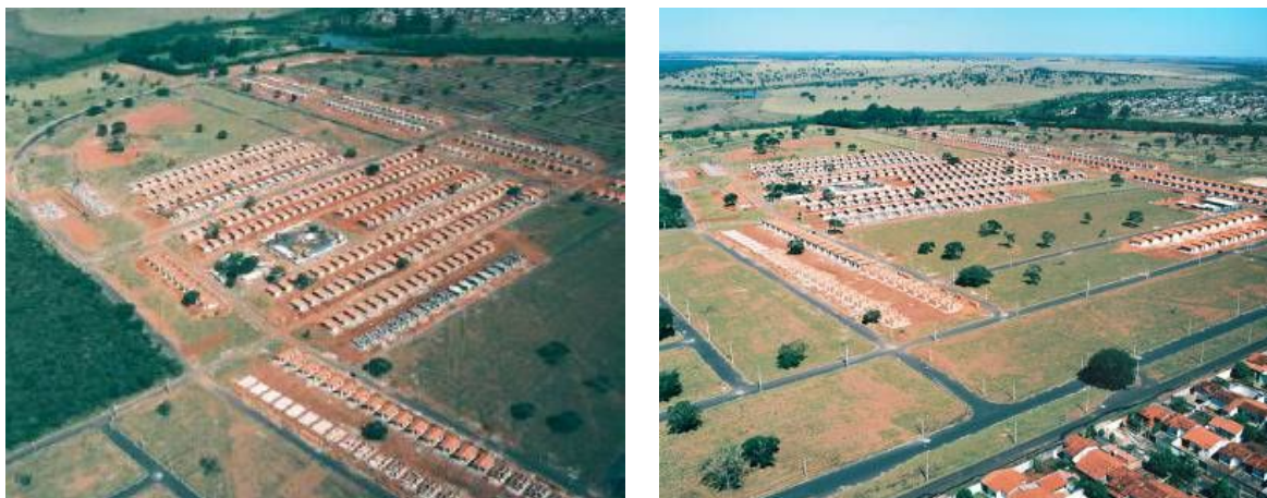
Figura 4.2 – Vista aérea do empreendimento completo - Vistas Leste e Norte
