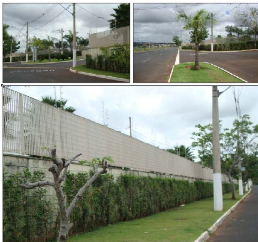
Mosaico 22: Uberlândia: muros do Condomínio Gávea Hill I
