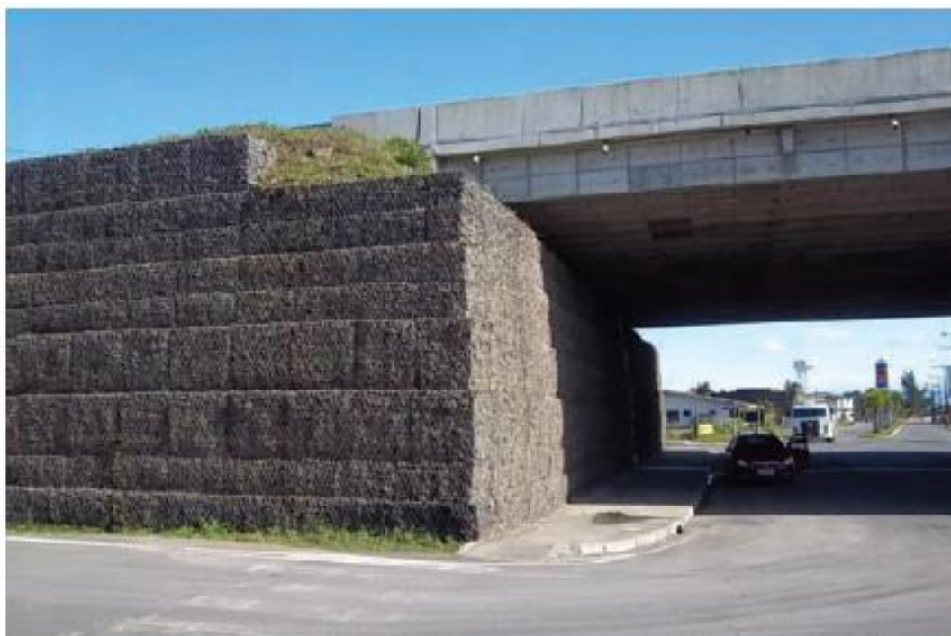
Figura 2 – Muro de solo reforçado sob o viaduto em Maracajá - SC.
