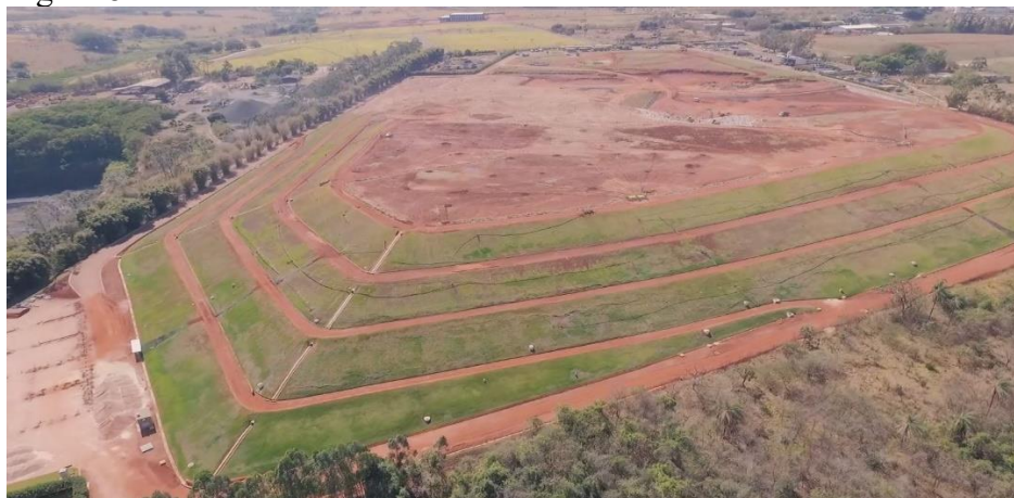
Figura 8 – Vista aérea atual aterro sanitário
