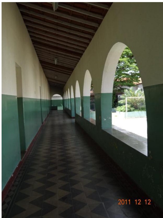
Figura 8 – Corredor interno. Fonte: Fotografia de Máira Scarpellini.
