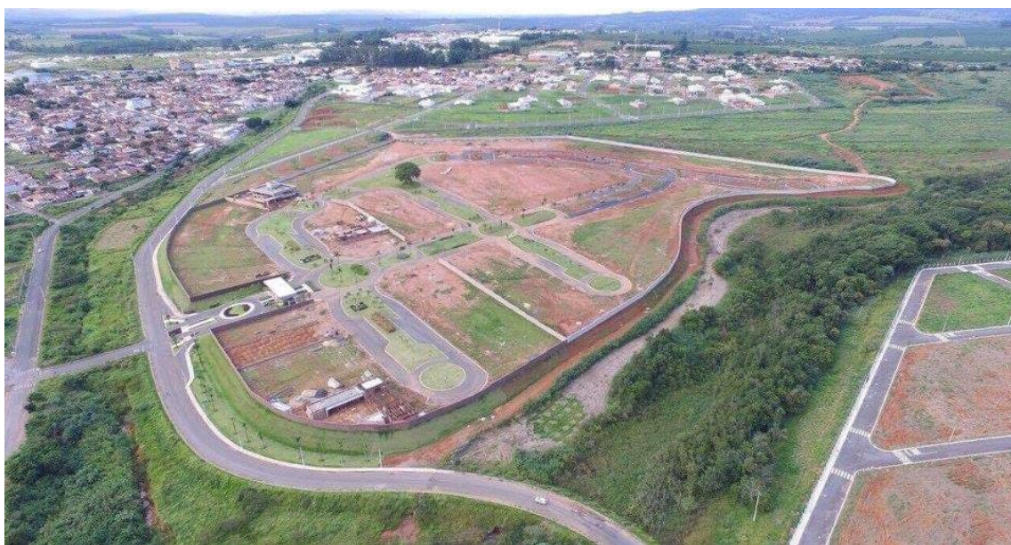
Figura 31. Patrocínio – MG: Condomínio Vila Vita em fase de construção.
