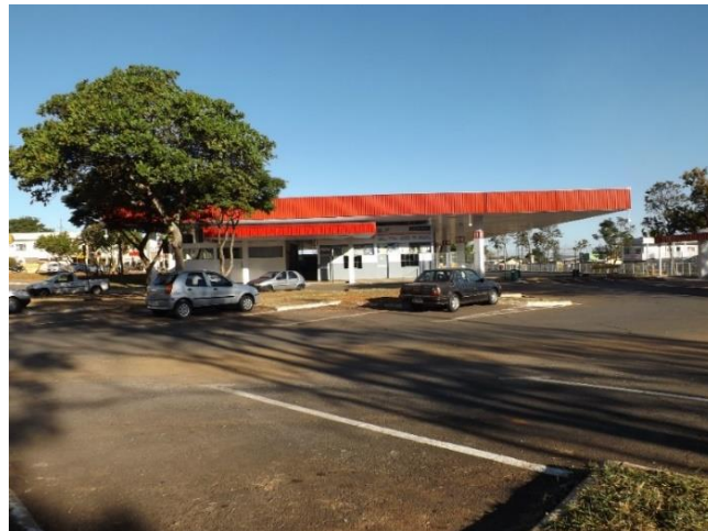
Figura 91. Patrocínio – MG: Praça da Rodoviária (estação).
