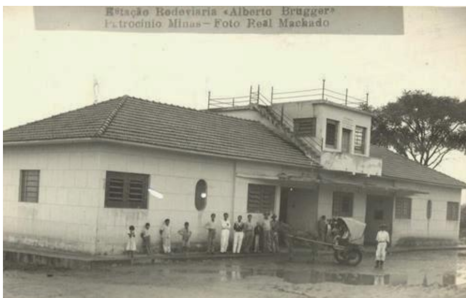
Figura 17. Patrocínio – MG: Estação Rodoviária.
