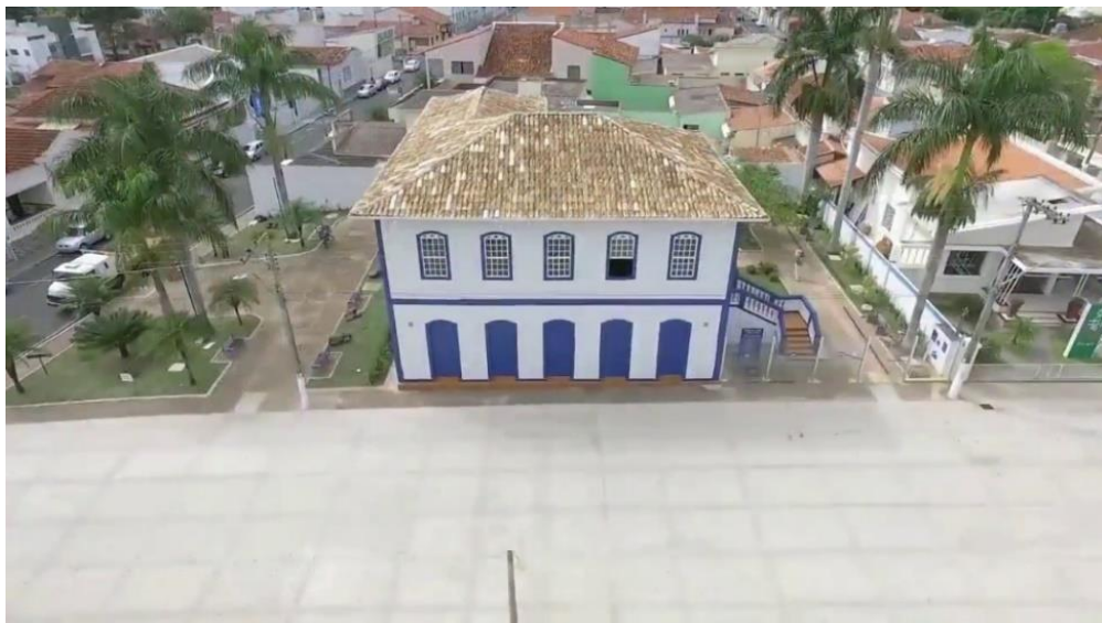
Figura 3. Patrocínio – MG: Calçada construído para fechar a rua entre a Praça da Matriz e a Casa da Cultura.
