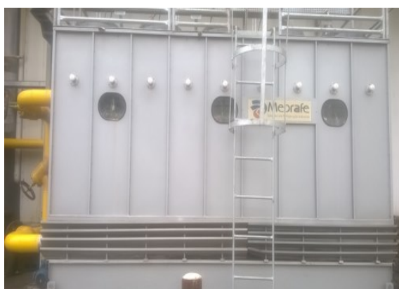
Figura 15-Trocador de calor do tipo subcooler (Hélio Creder,2004).
