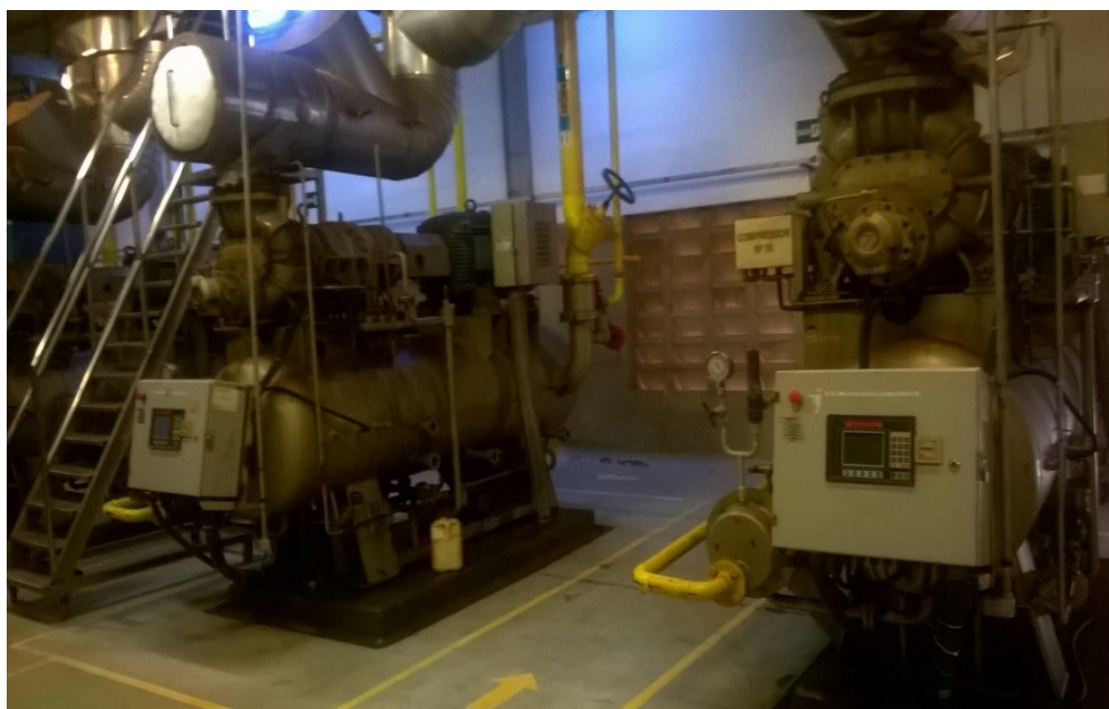
Figura 06-Compressores Parafuso MYCOM (Autor).
