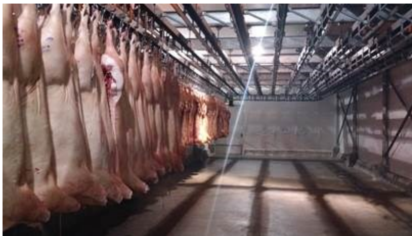
Figura13-Camara de Congelamento de Carcaças Parcialmente Preenchida.
