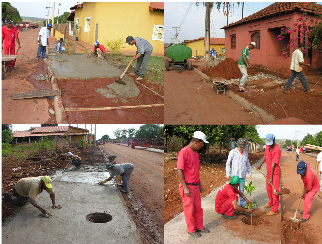
FIGURA 10: Construção das Calçadas no Povoado do Sarandi (Acervo DECOM – Departamento de Comunicação da Prefeitura Municipal de Itumbiara, (GO))
