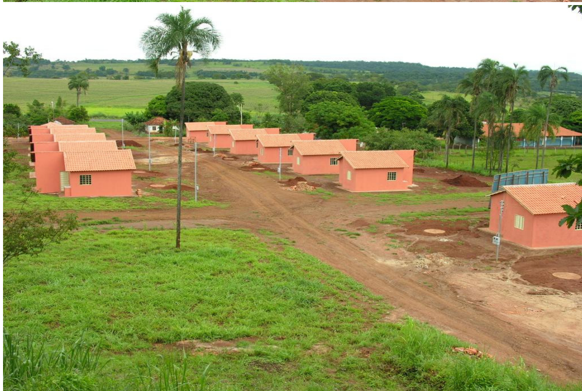
FIGURA 11: Construção de 30 Casas Populares no Povoado do Sarandi (Acervo DECOM – Departamento de Comunicação da Prefeitura Municipal de Itumbiara, (GO))
