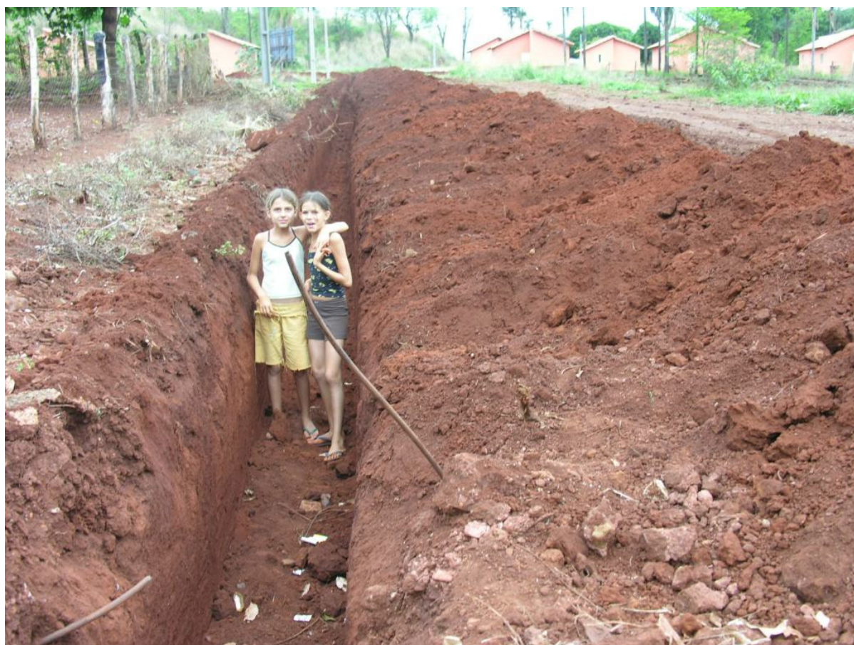
FIGURA 07: Reforma da Rede de Água no povoado do Sarandi, (Acervo DECOM – Departamento de Comunicação da Prefeitura Municipal de Itumbiara, (GO))
