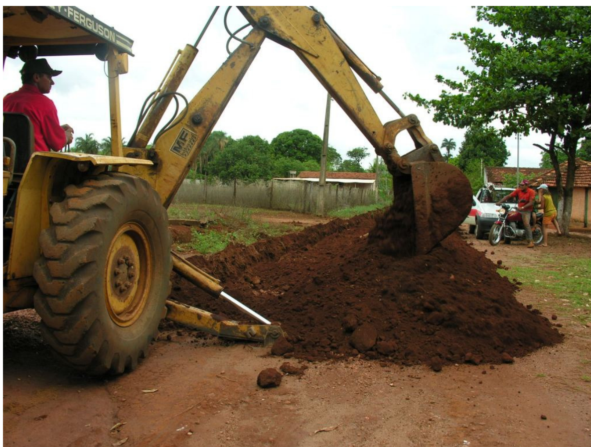
FIGURA 06: Reforma da Rede de Água no povoado do Sarandi, (Acervo DECOM – Departamento de Comunicação da Prefeitura Municipal de Itumbiara, (GO))
