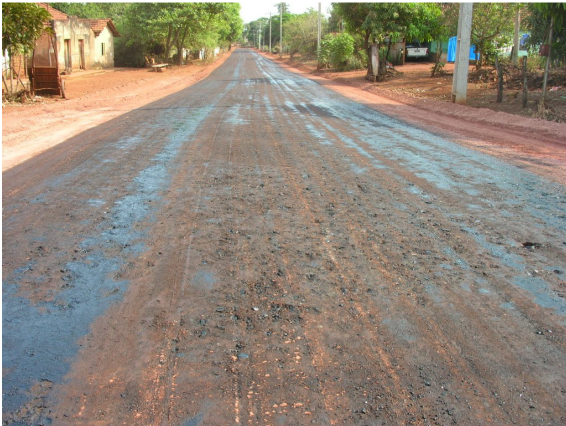
FIGURA 08: Asfaltamento do Povoado do Sarandi (Acervo DECOM – Departamento de Comunicação da Prefeitura Municipal de Itumbiara, (GO))
