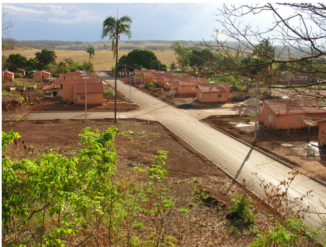
FIGURA 12: Asfaltamento nas ruas onde foram construídas 30 Casas Populares no Povoado do Sarandi (Acervo DECOM – Departamento de Comunicação da Prefeitura Municipal de Itumbiara, (GO))
