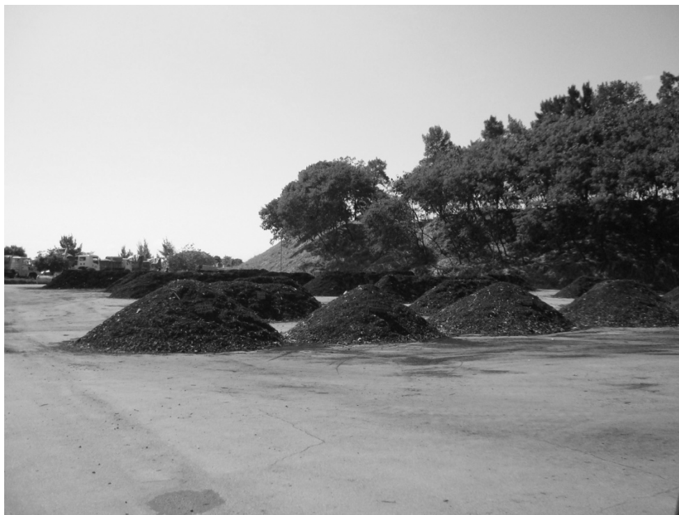
Figura 12: Pátio de compostagem dos resíduos orgânicos implantado no aterro sanitário de Belo Horizonte.
