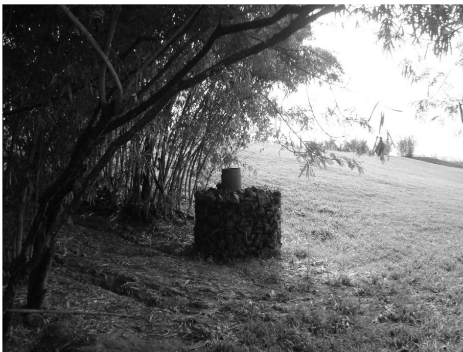
Figura 20: Queimador de biogás na área monitorada no aterro Parque Santa Bárbara em Campinas-SP.
