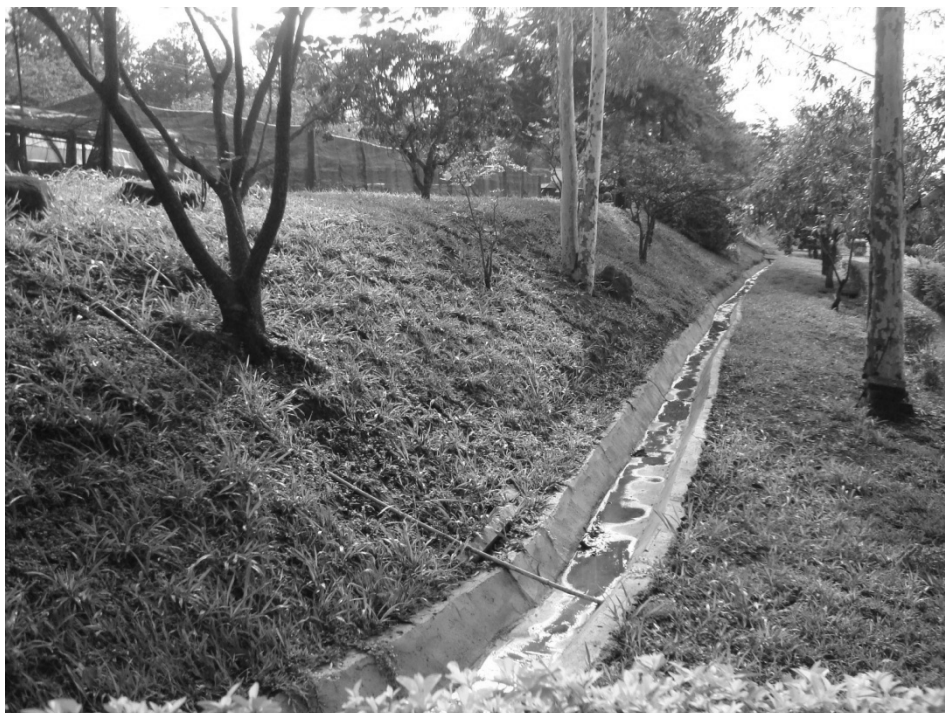
Figura 19: Canaleta de drenagem pluvial na área monitorada no aterro Parque Santa Bárbara em Campinas-SP.
