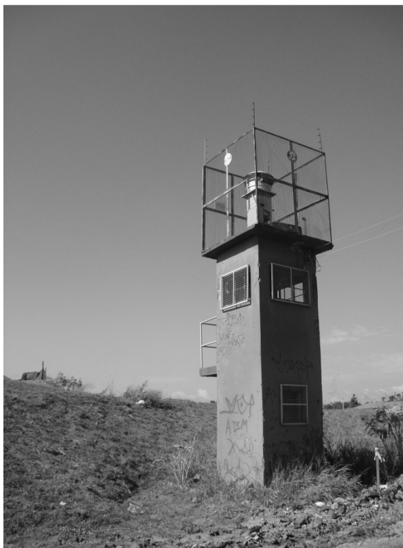
Figura 18: Estação de monitoramento do ar no aterro sanitário de Belo Horizonte. Fonte: A autora, 2009.
