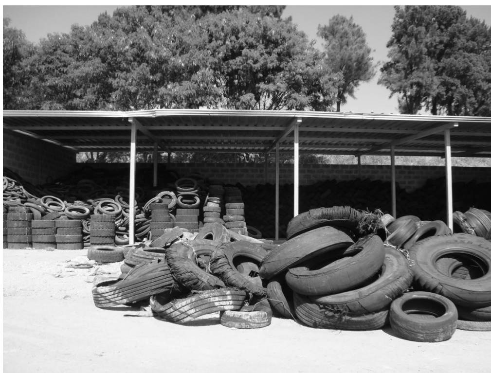
Figura 13: Galpão para recebimento de pneus implantado no aterro sanitário de Belo Horizonte.
