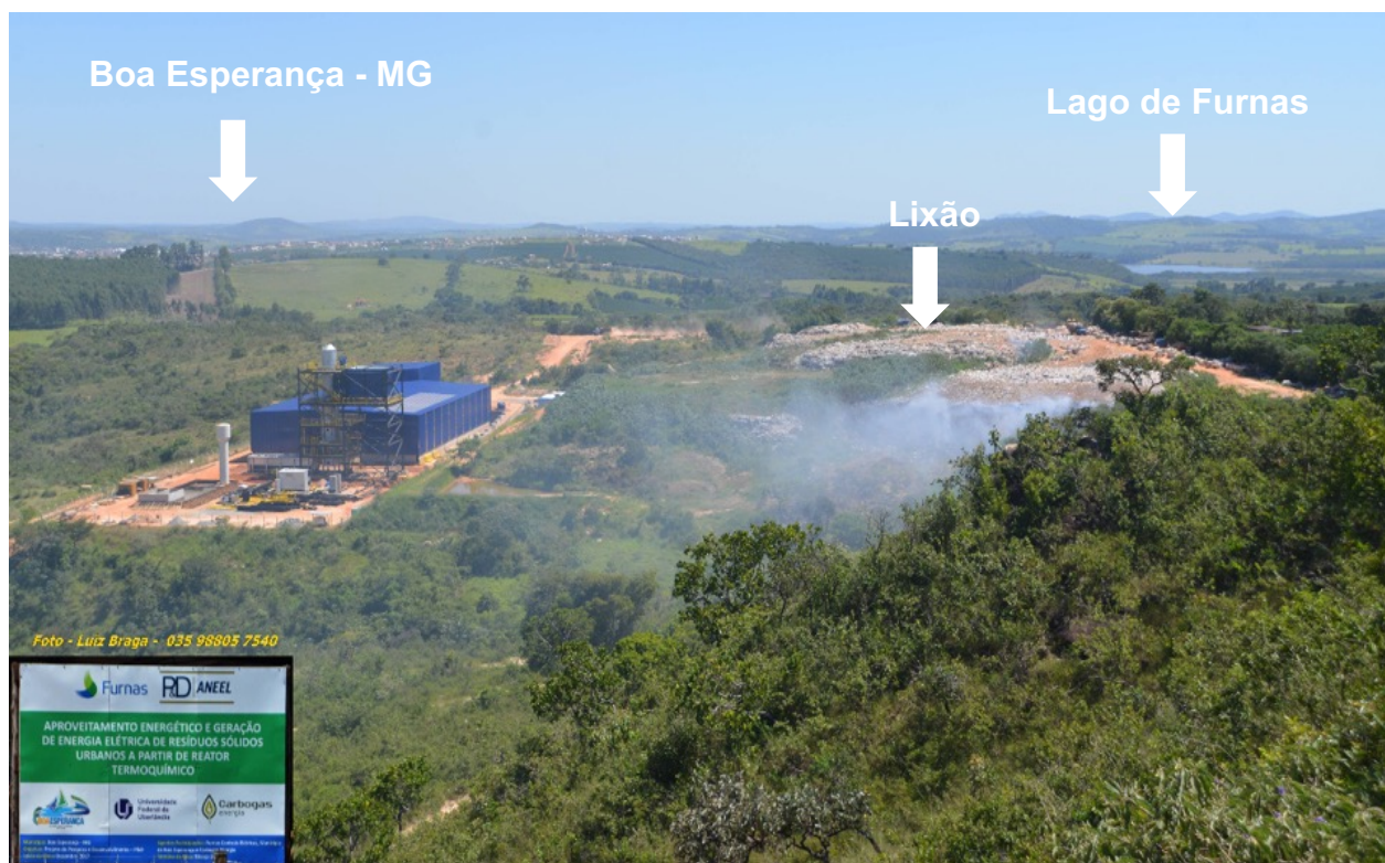
Fig.4.7. Vista aérea da Usina Termoquímica em construção ao lado do lixão do município de Boa Esperança – MG (fevereiro de 2019).
