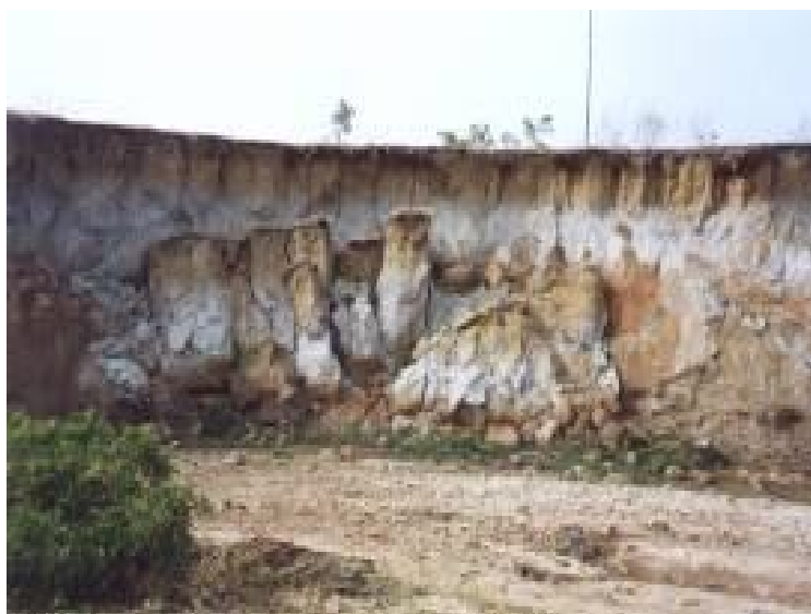
FIGURA 7.14 – Movimentação de massas devido ao impacto das águas pluviais. Data: 16/09/2004.
