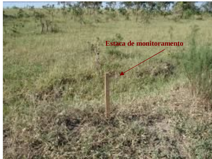
FIGURA 7.27 – Estacas de monitoramento da voçoroca.
