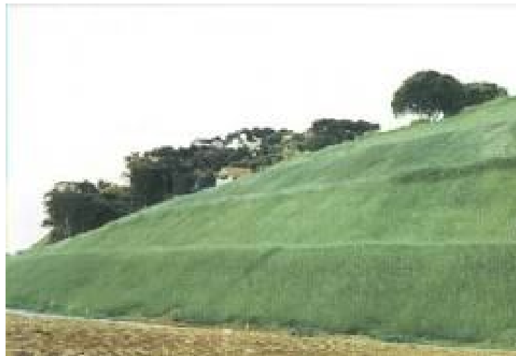
FIGURA 8.2 – Talude depois da aplicação da hidrossemeadura. Fonte: Conspizza Hidrossemeadura
