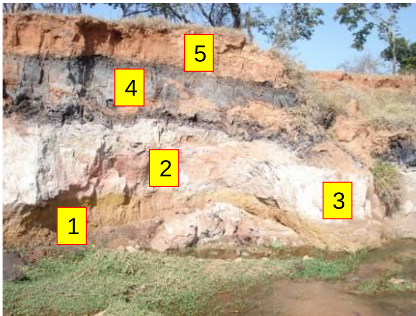
FIGURA 6.3 – Talude do córrego Campo Alegre. Data: 13 de fevereiro de 2005.
