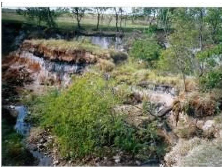
FIGURA 7.5 – Volume de solo, aproximadamente com 12 metros x 6 metros x 10 metros. Data: 16/09/2004.
