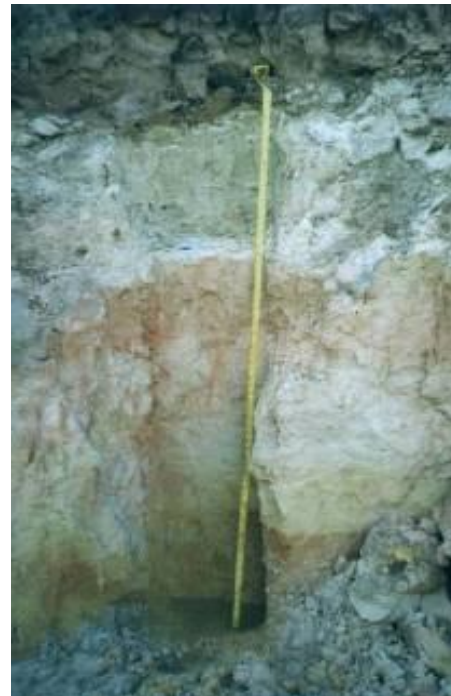
FIGURA 4.6 – Talude da vereda do córrego Campo Alegre. Data: 15/02/2006.
