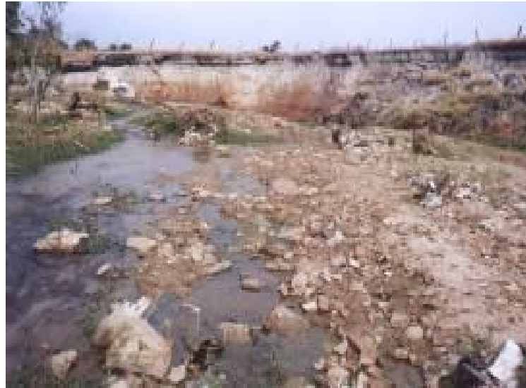
FIGURA 7.16 – Assoreamento do córrego com entulhos de construção civil. Data: 16/09/2004.
