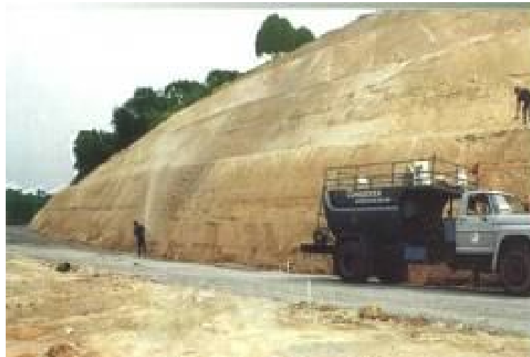
FIGURA 8.1 – Talude antes da aplicação da hidrossemeadura. Fonte: Conspizza Hidrossemeadura
