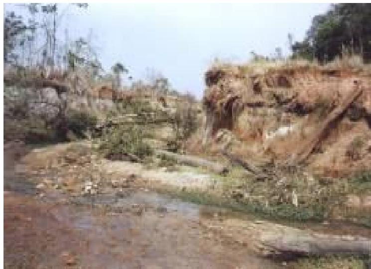
FIGURA 7.12 – Degradação ambiental devido ao impacto das águas pluviais. Data: 16/09/2004.
