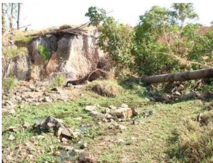
FIGURA 7.24 – Queda de vegetação. Data: 22/07/2007.
