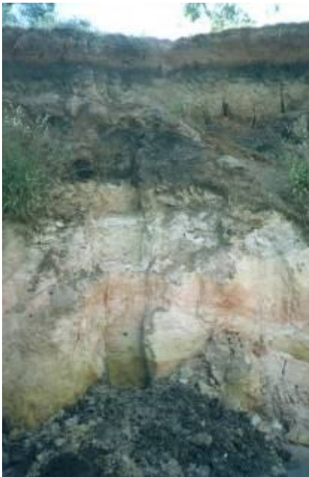
FIGURA 4.5 – Talude da vereda do córrego Campo Alegre. Data: 15/02/2006.
