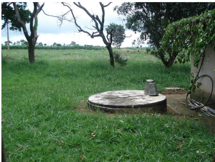
Figura 24 – Cisterna localizada na Estância Buritis, onde foram realizadas leituras do n.a. Área Experimental IV – Ponto 1 - Autor: SOARES, 2006
