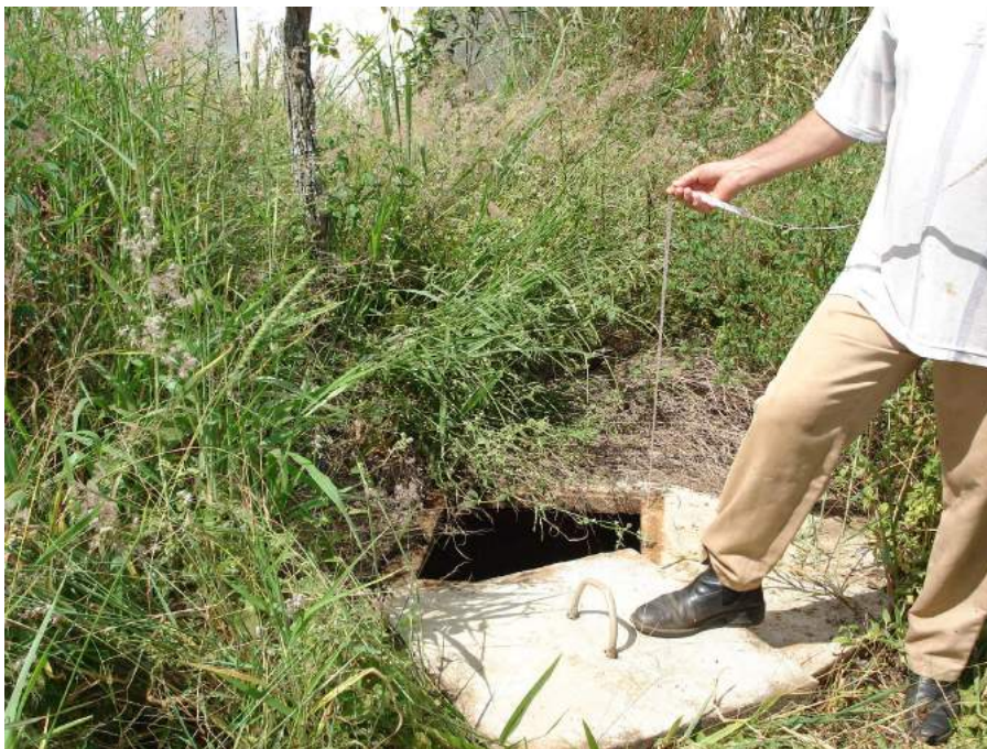
Figura 25. Cisterna localizada em antiga estação ferroviária, próximo à Estância Buritis. Área Experimental IV – Ponto 3. Autor: SOARES, 2006.
