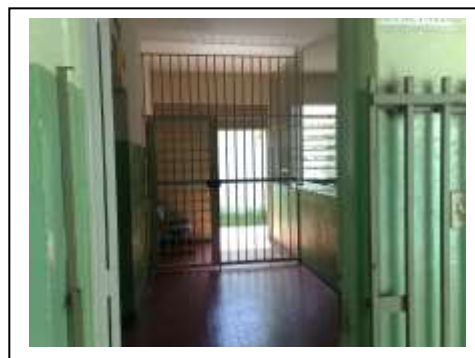
Figura 3 – Portão interno visto de dentro
