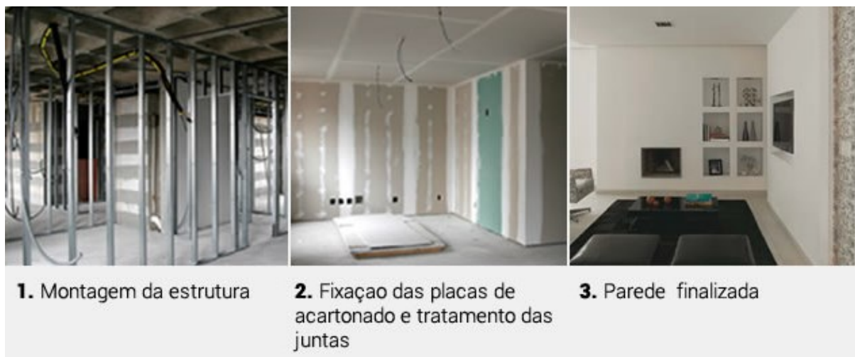
Figura 2 - Etapas de execução do Drywall
