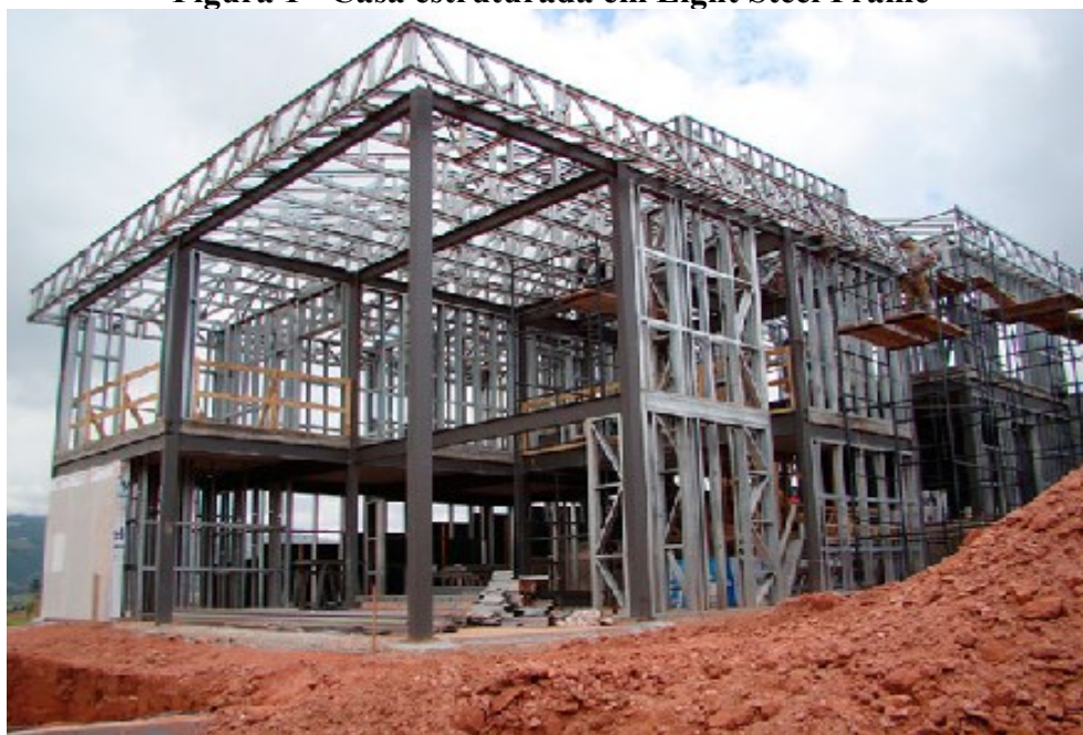
Figura 1 - Casa estruturada em Light Steel Frame
