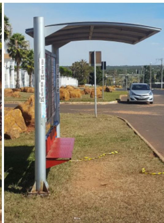
FIGURA 39: Novos abrigos de ponto de ônibus Fonte: Autora
