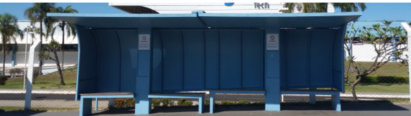
FIGURAS 13, 14, 15 e 16: Análise dos pontos de ônibus com vedação em fibra de vidro Fonte: Autora
