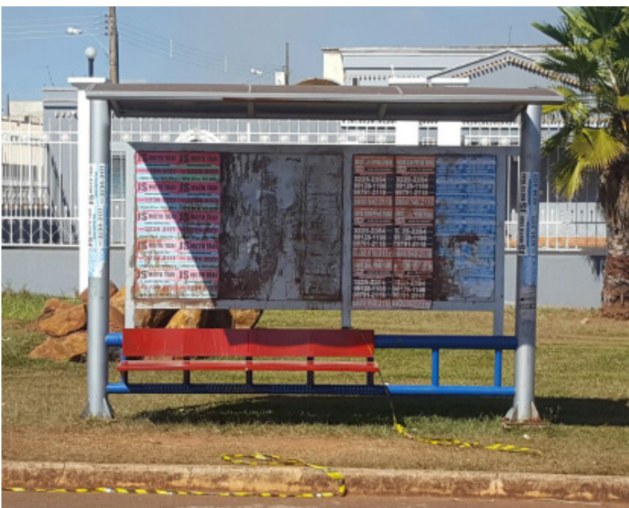
FIGURA 38: Novos abrigos de ponto de ônibus Fonte: Autora
