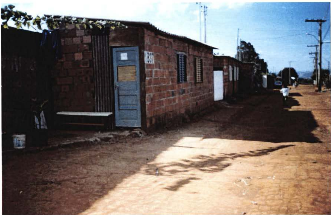
Rua Silos. Bairro Minas-Gerais - 2006. (Arquivo da autora).
