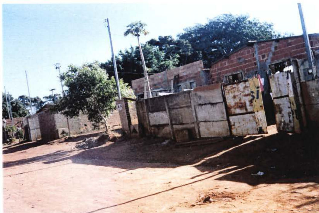
Rua Silos. Bairro Minas-Gerais. 2006 Arquivo da autora.
