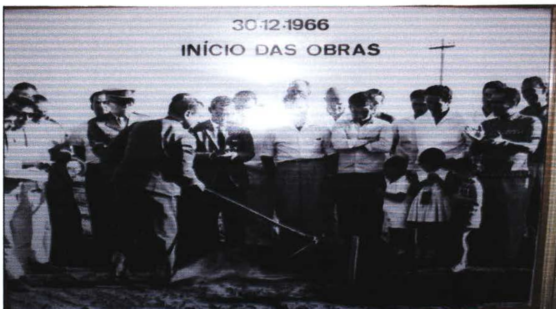
2) A primeira enxadada – Lançamento da Pedra Fundamental do bloco de cadeiras básicas pelo Dr. Rondon Pacheco. Fonte: www. hc. ufu. br /NPM - Acesso em 20/02/2008.
