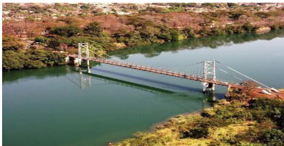
Figura 7 - Ponte Afonso Pena
