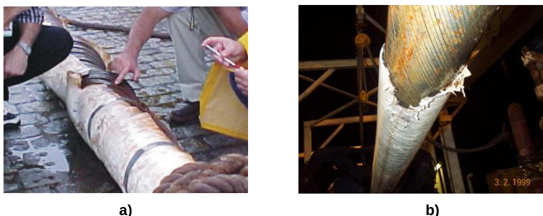
Figura 2.11 – Desgaste na linha flexível: a) Perda total do revestimento externo seguido de falha da tubulação por corrosão b) Perda total do revestimento externo.
