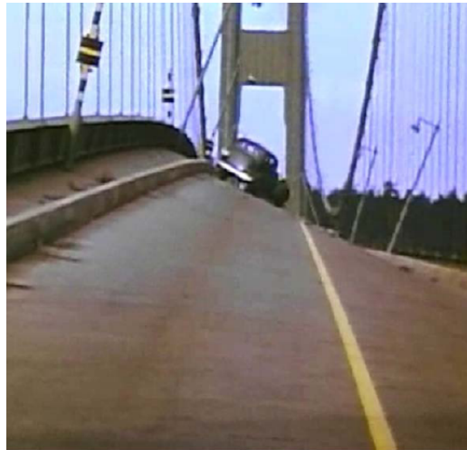
Figura 2.5: Ruína da ponte Tacoma Narrows, devido à condição de ventos constantes, em 1940, Campregher (2005).
