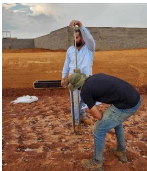
Figura 4 – Execução do ensaio DCP na camada de sub-base
