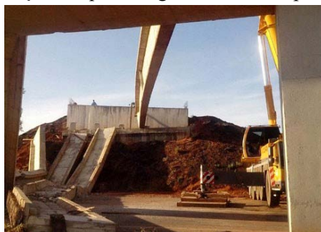
(c) Colocação da quarta viga e as demais após a queda
