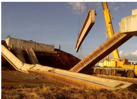
(c) Colocação da quarta viga e as demais após a queda
