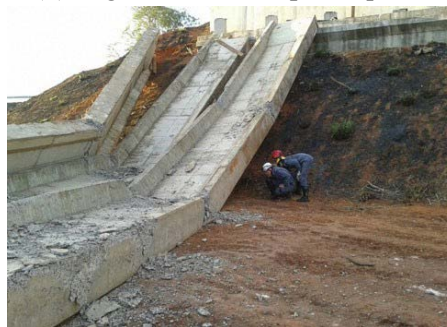
(c) Colocação da quarta viga e as demais após a queda
