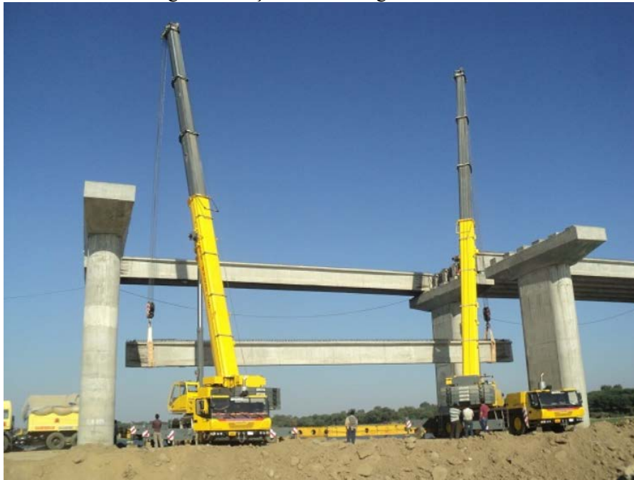
Figura 1.1: Içamento de Viga de Viaduto
