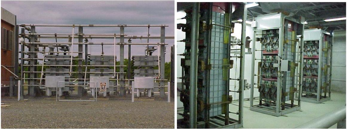
Figura 2.17 - Ilustração do Capacitor Chaveado a Tiristor – CCT.
