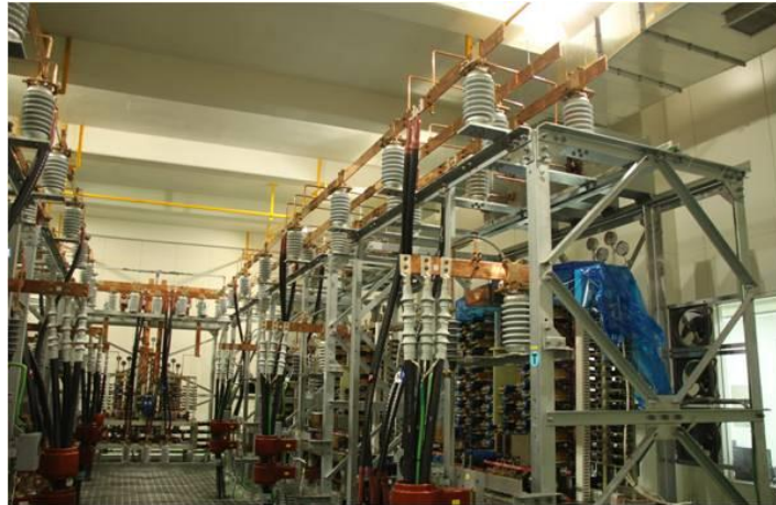
Figura 2.20 - Unidades que compõem o STATCOM.
