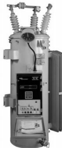
Figura 2.23 – Foto do equipamento Cooper VR-32
