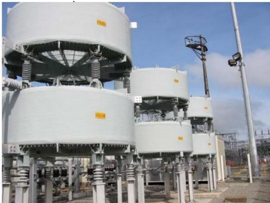
Figura 2.15 - Ilustração de um Reator Controlado a Tiristores – RCT.
