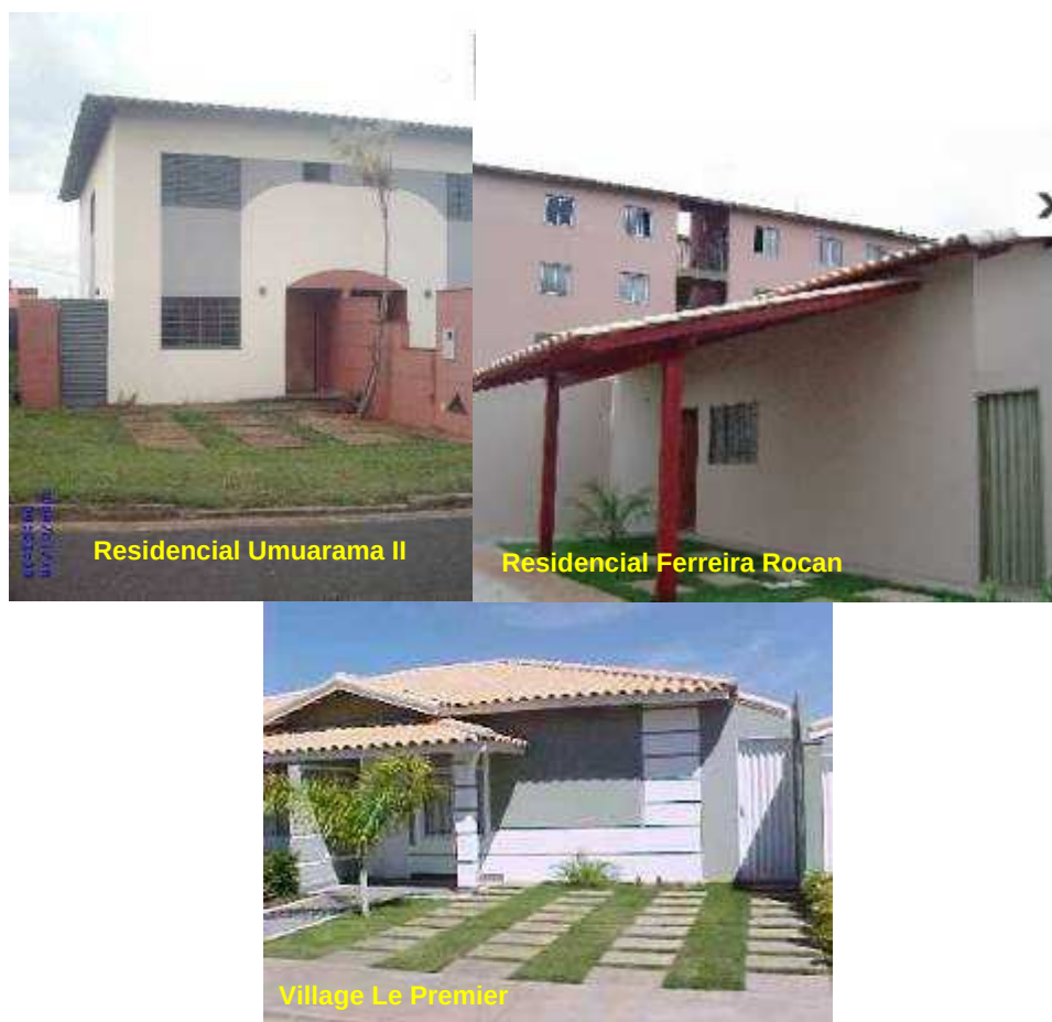
Figura 136 – Uberlândia: exemplos de casas nos condomínios destinados aos grupos de renda média e média-baixa, 2008
