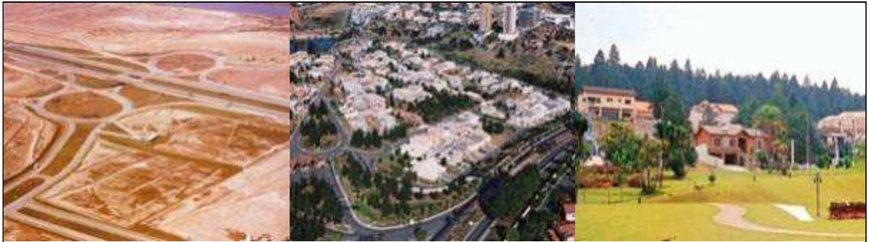
Figura 5 - São Paulo: vista parcial da construção do Condomínio AlphaVille
