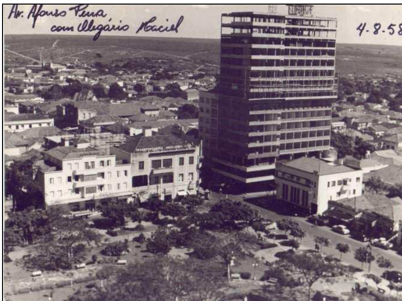
Figura 17 – Uberlândia: Edifício Tubal Vilela, 1958
