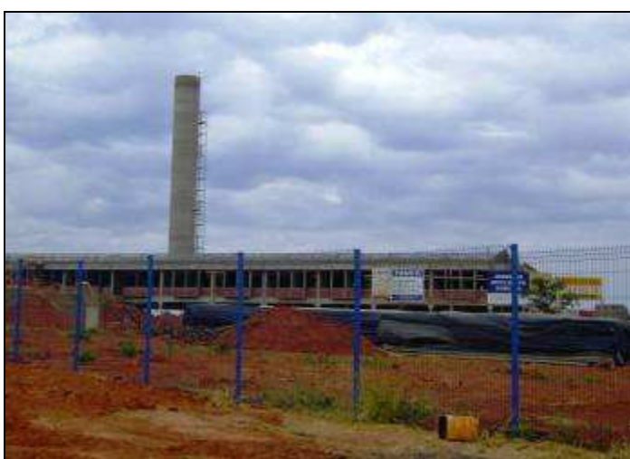
Figura 89 – Uberlândia: hospital municipal em construção na Área 1 do Setor Sul, 2008
