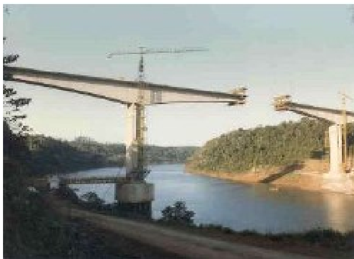
Figura 2 - Ponte protendida em balanços sucessivos.
