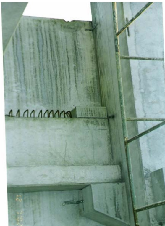
Figura 14 - Consolo de fixação vertical dos painéis de vedação.
