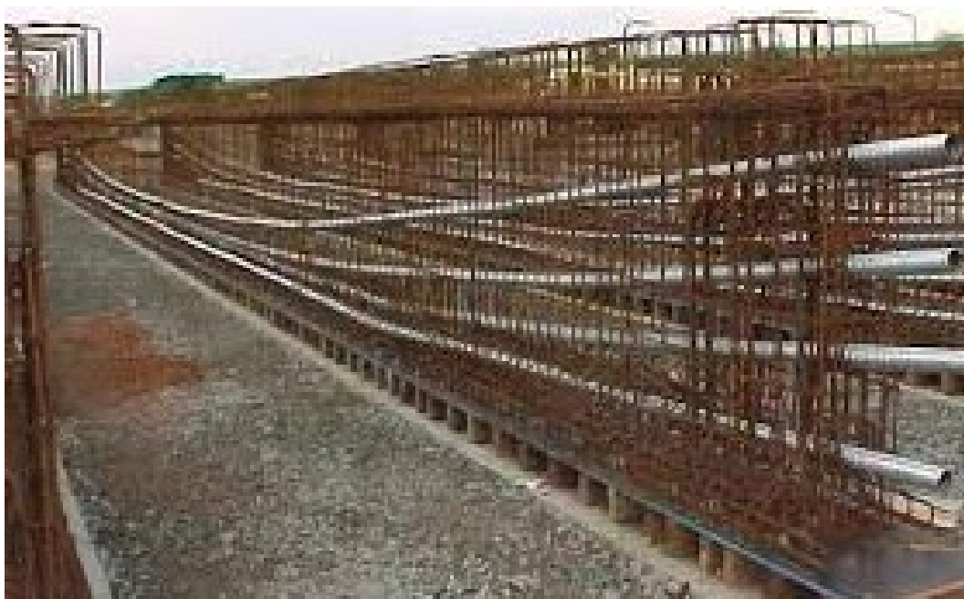
Figura 5 - Exemplo de curvatura de protensão.
