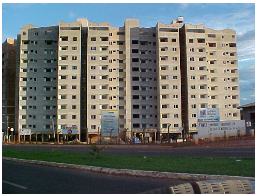
Figura 08 - Empreendimento turístico em construção, Caldas Novas (GO), 2005.
