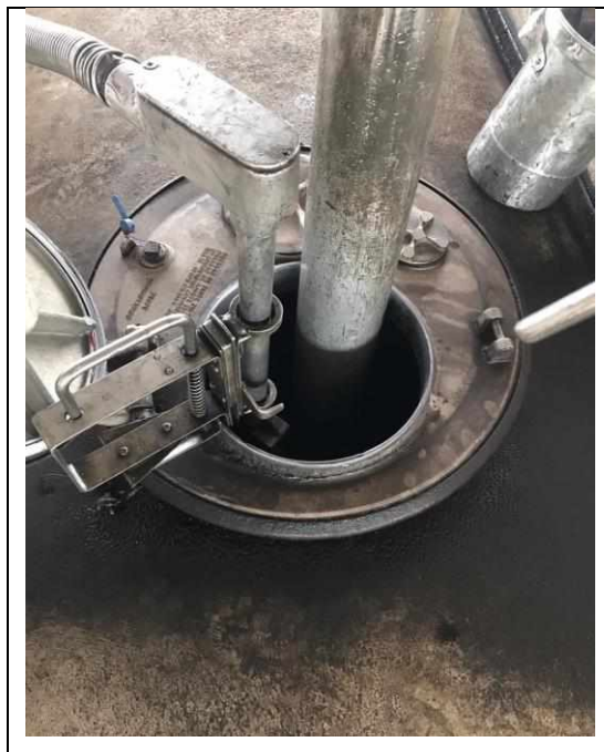
Figura 9 - Sistema Overflow Top-Loading (Antes)
