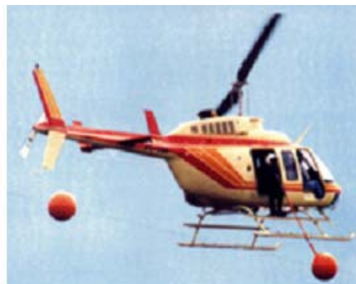
Figura 2.2. Instalação de esferas de sinalização com o auxílio de helicóptero.
