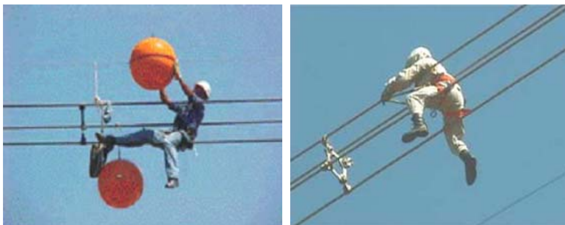
Figura 2.3. Instalação de esferas de sinalização por um eletricista sobre o cabo.
