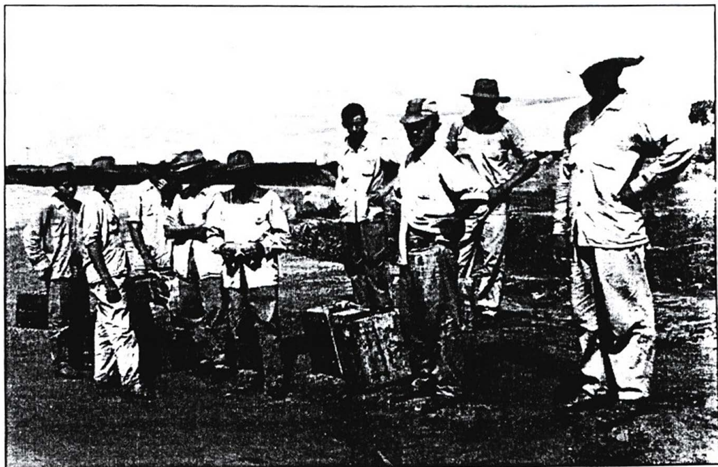
Grupo de trabalhadores chegando à Brasília, outubro/1959. Fundo: NOVACAP.
