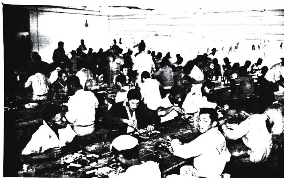
Refeitório em canteiro de obras do IAPB(Instituto de Aposentadoria e Pensões dos Bancários). 35
