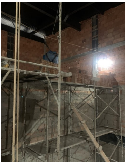
Figura 5 – Execução de alvenaria em blocos cerâmicos
