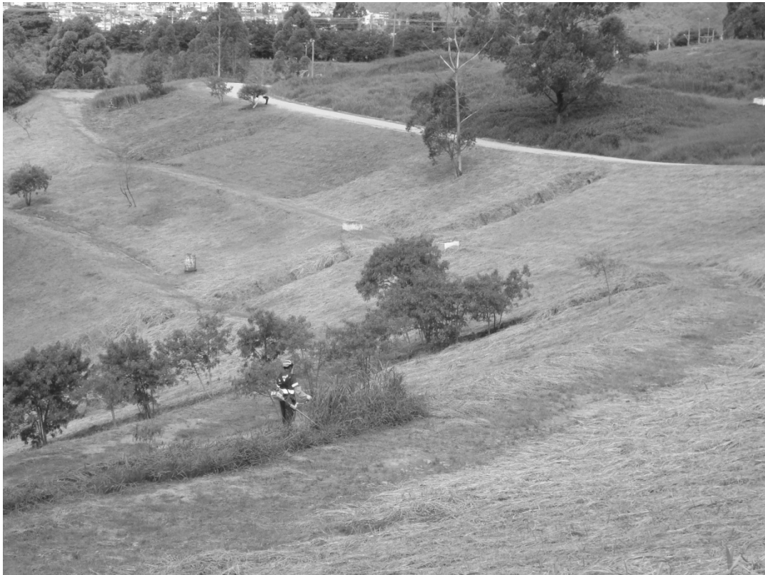
Figura 31: Funcionário realizando a manutenção da cobertura vegetal no aterro Bandeirantes, São Paulo - SP.
