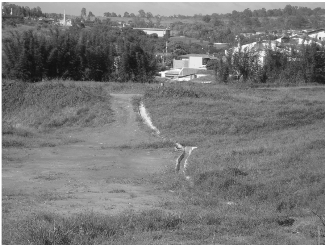
Figura 28: Irregularidade na conformação do terreno e falhas na cobertura vegetal, aterro Parque Santa Bárbara em Campinas - SP.
