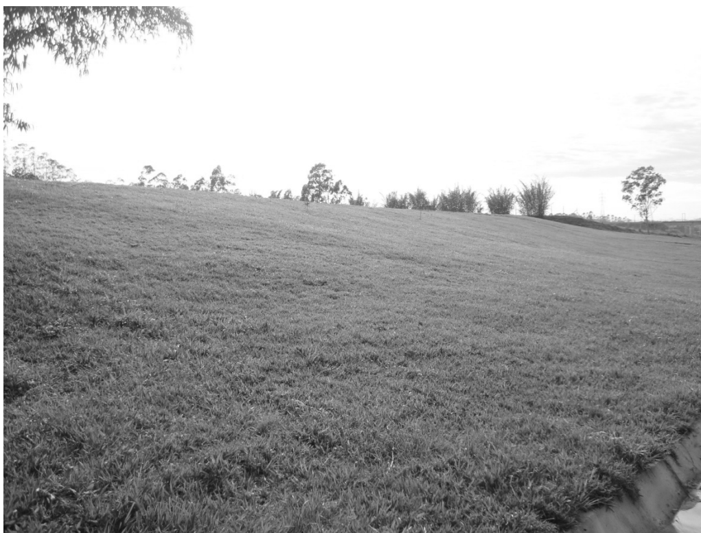
Figura 23: Detalhe da boa conservação do talude na área monitorada, área de lazer no aterro Parque Santa Bárbara em Campinas-SP.
