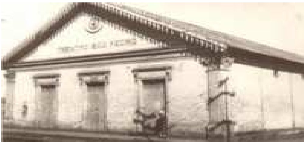
Foto 9: Fachada do Cine Theatro São Pedro
