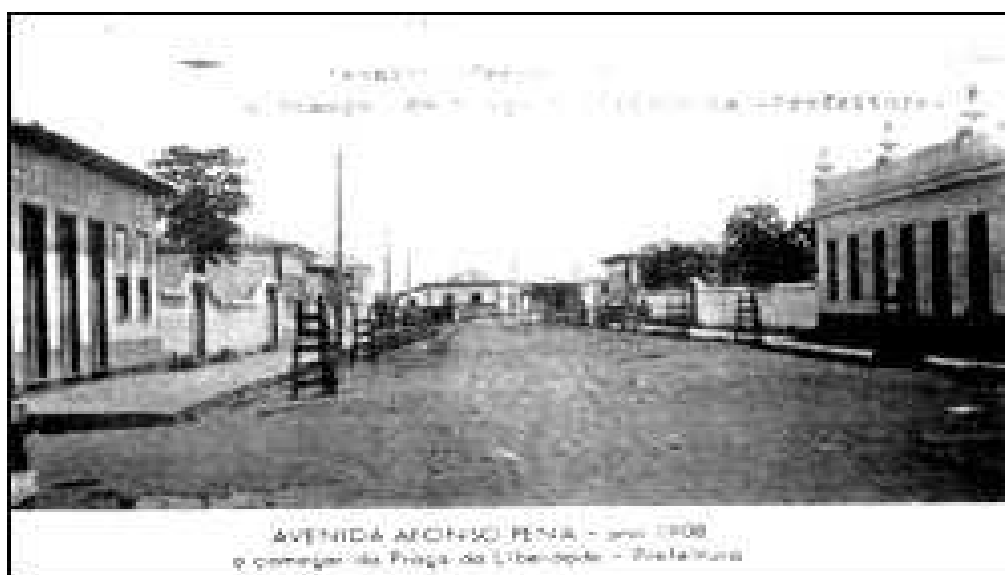
Foto 1: Avenida Afonso Pena em 1908, antes da chegada dos cinemas.
