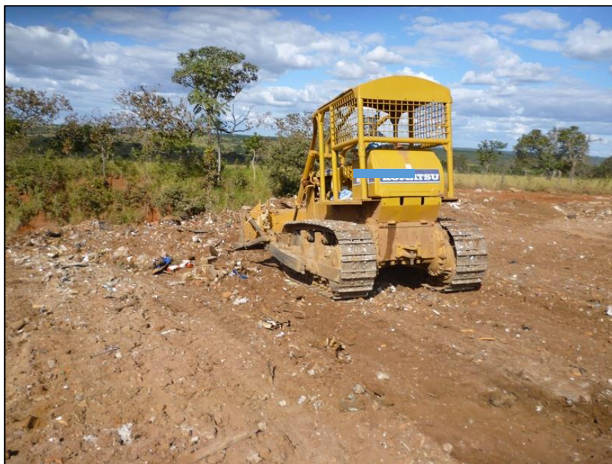
Figura 38 – Uberlândia: trator de esteira esparramando o resíduos, 2.012
