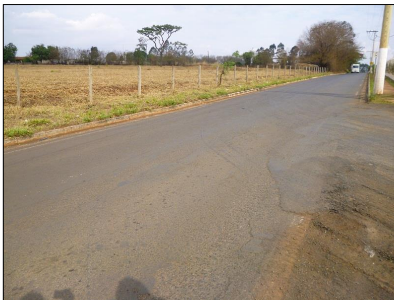
Figura 48 – Uberlândia: avenida construída com RCD como base, 2.012
