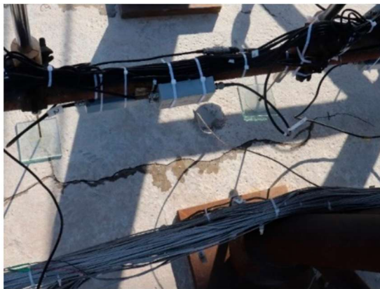
Figura 9: Abertura de fissuras na face oposta ao incêndio devido à microfissuração do composto e a pressão de fuga de água com 27 minutos de ensaio (DUAN et al. , 2023)
