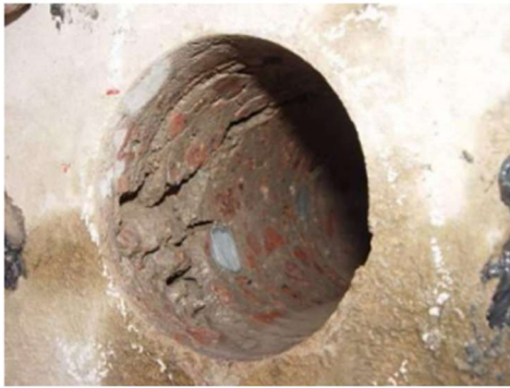
Figura 35: Extração de testemunho de concreto (LORENZI, 2019)
