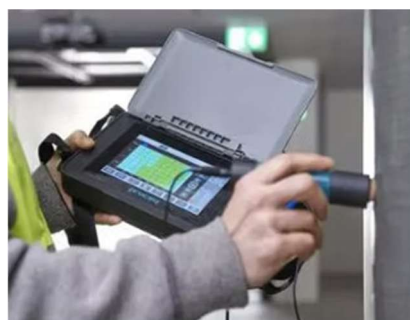
(e) Ensaio de Potencial de Corrosão
