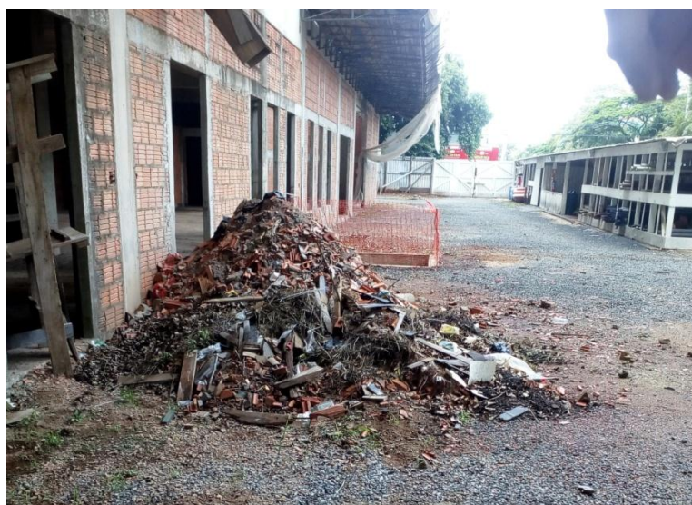
Figura 8 - Entulho segregado da obra do hospital 8DJU.
