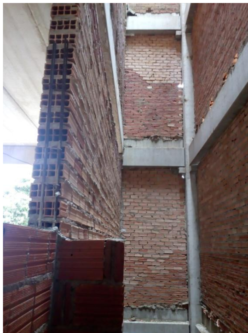
Figura 10 - Tijolos deitados para a melhor utilização do material.
