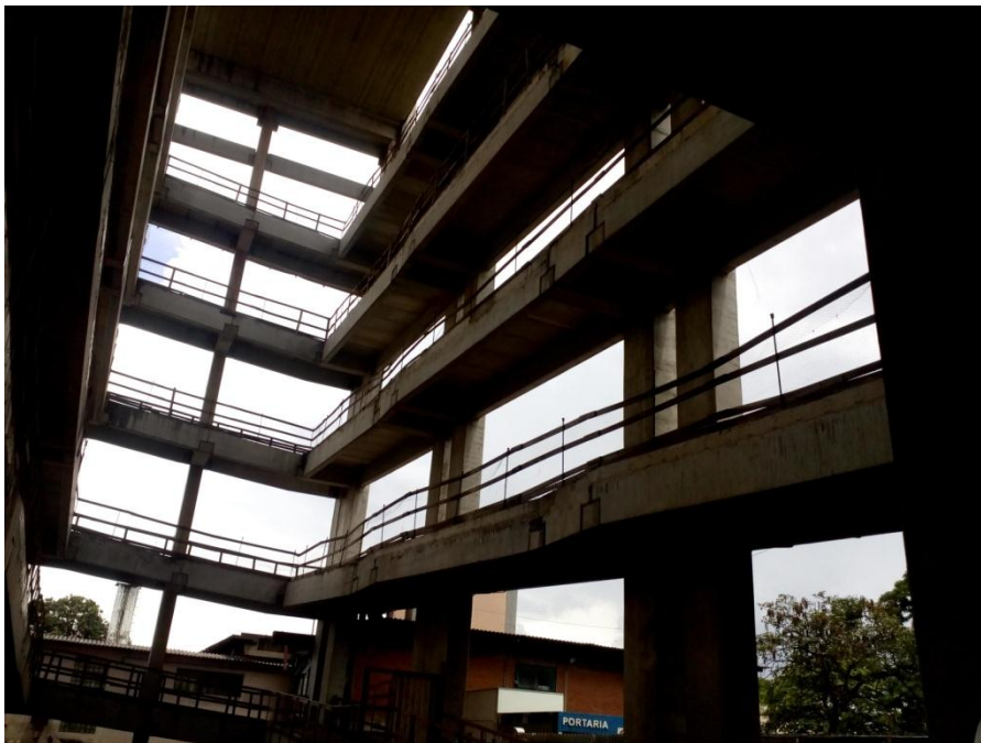
Figura 13 - Rampas com planejamento de instalação de vidro.
