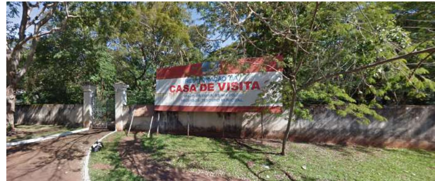
Figura 98 - Placa de obras da prefeitura indicando projeto de restauração da Casa de Visitas, 2012
