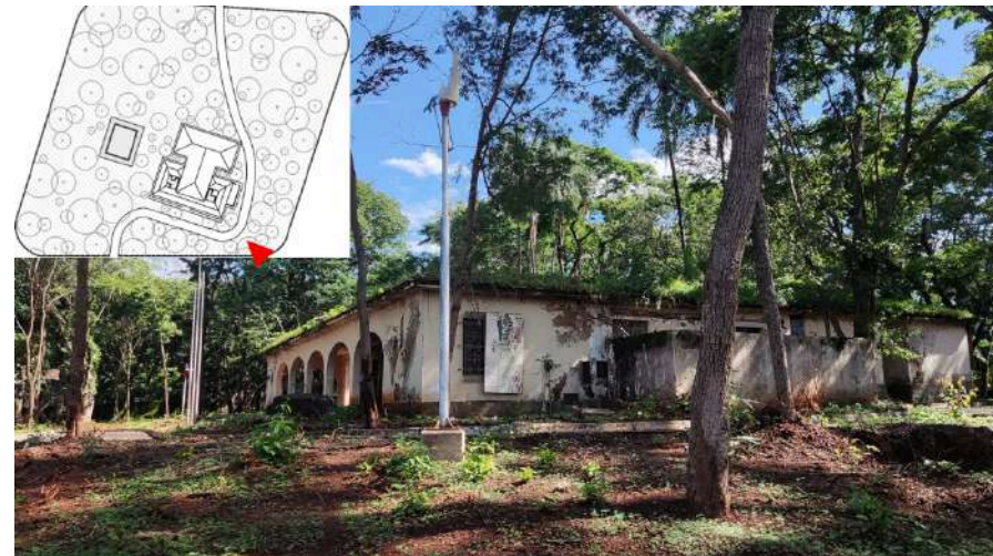
Figura 233 - Vista da fachada Lateral
