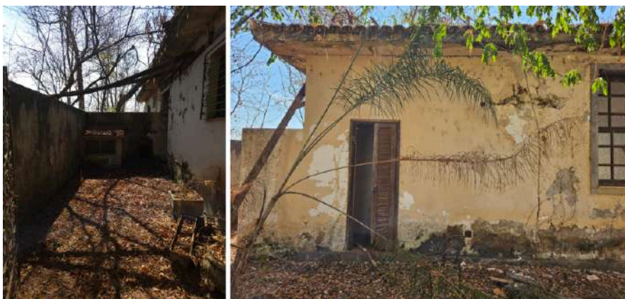
Figura 119 e 120 - Fundos da área de serviço.
