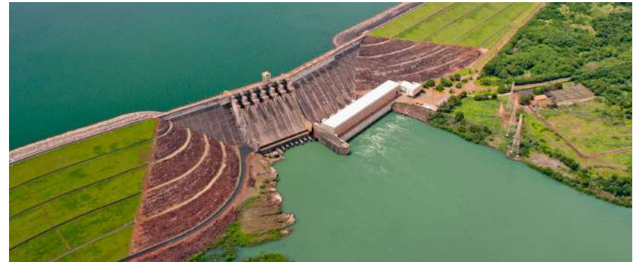
Figura 75 - Usina Hidrelétrica de Furnas em Itumbiara.
