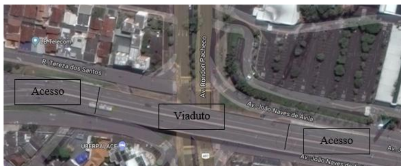
Figura 25 - Viaduto da Avenida João Naves de Ávila sobre a Avenida Rondon Pacheco, vista superior. Fonte Google Earth (2018).
