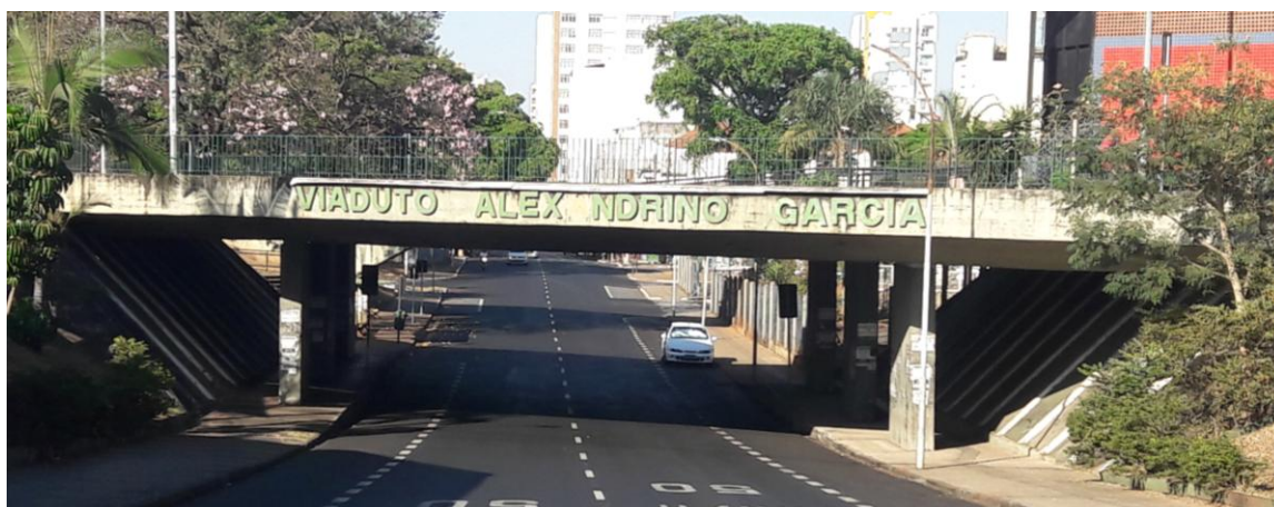
Figura 29 - Viaduto Alexandrino Garcia (Av. Afonso Pena).
