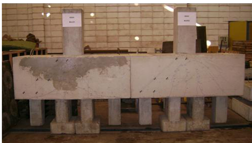
Figura 11 - Panorama de fissuração dos blocos.
