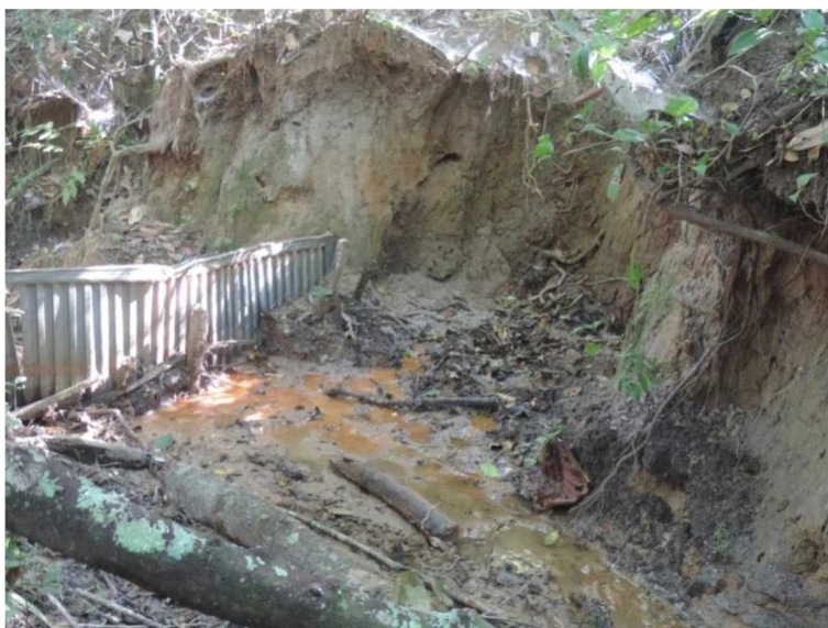
Figura 7 Mina pisoteada em processo de assoreamento.
