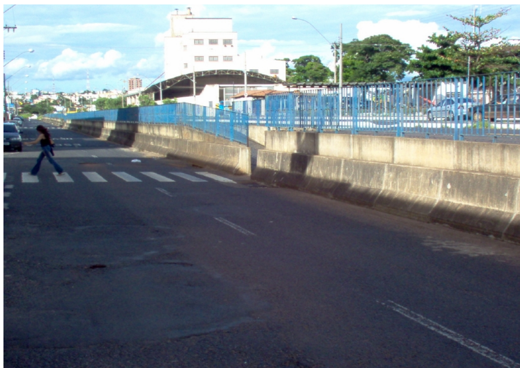
FOTO 05: Foto da parte central da avenida que se estende até o Moinho de Trigo Sete Irmãos, 2005. Em destaque, elevado construído para garantir o trânsito livre dos ônibus no corredor central da avenida. Foto tirada pelo autor.
