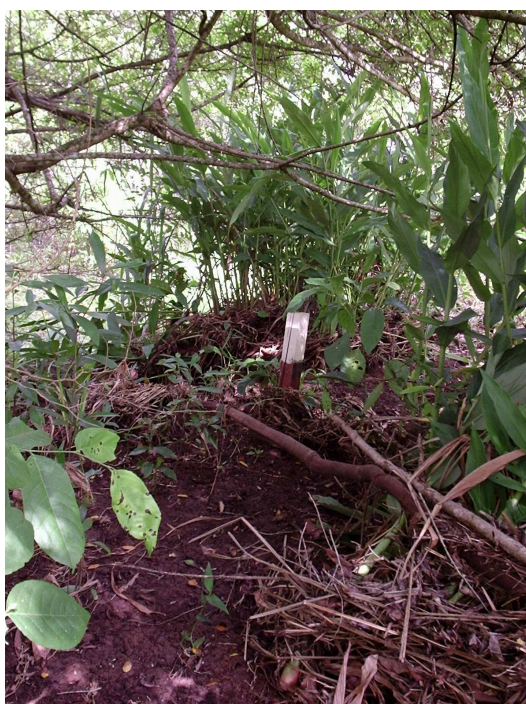
Figura 18: Seção I – Estação Sede – Observa-se galhos e vegetação próximo ao braço da voçoroca na tentativa de conter o avanço da erosão.
