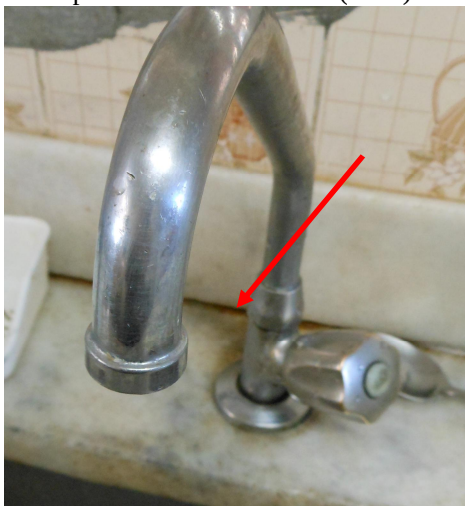
Foto 3.21 – Escola 39.14: torneira da cozinha apresentando vazamento (2012)
