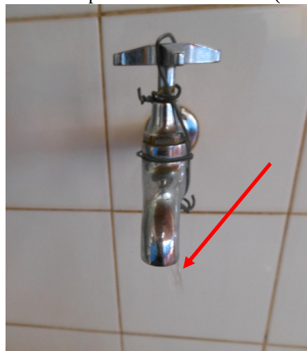
Foto 3.22 – Escola 39.14: torneira do bebedouro apresentando vazamento (2012)
