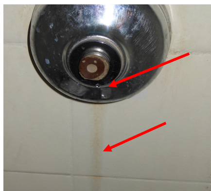
Foto 3.21 – Escola 39.14: torneira da cozinha apresentando vazamento (2012)
