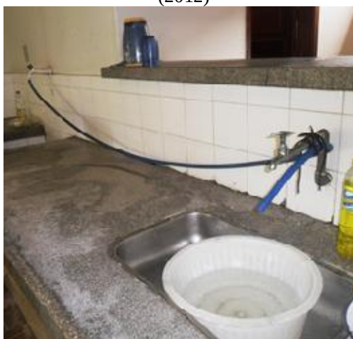
Foto 3.10 – Escola 34.10: adaptação existente na cozinha para possibilitar o uso da cuba (2012)
