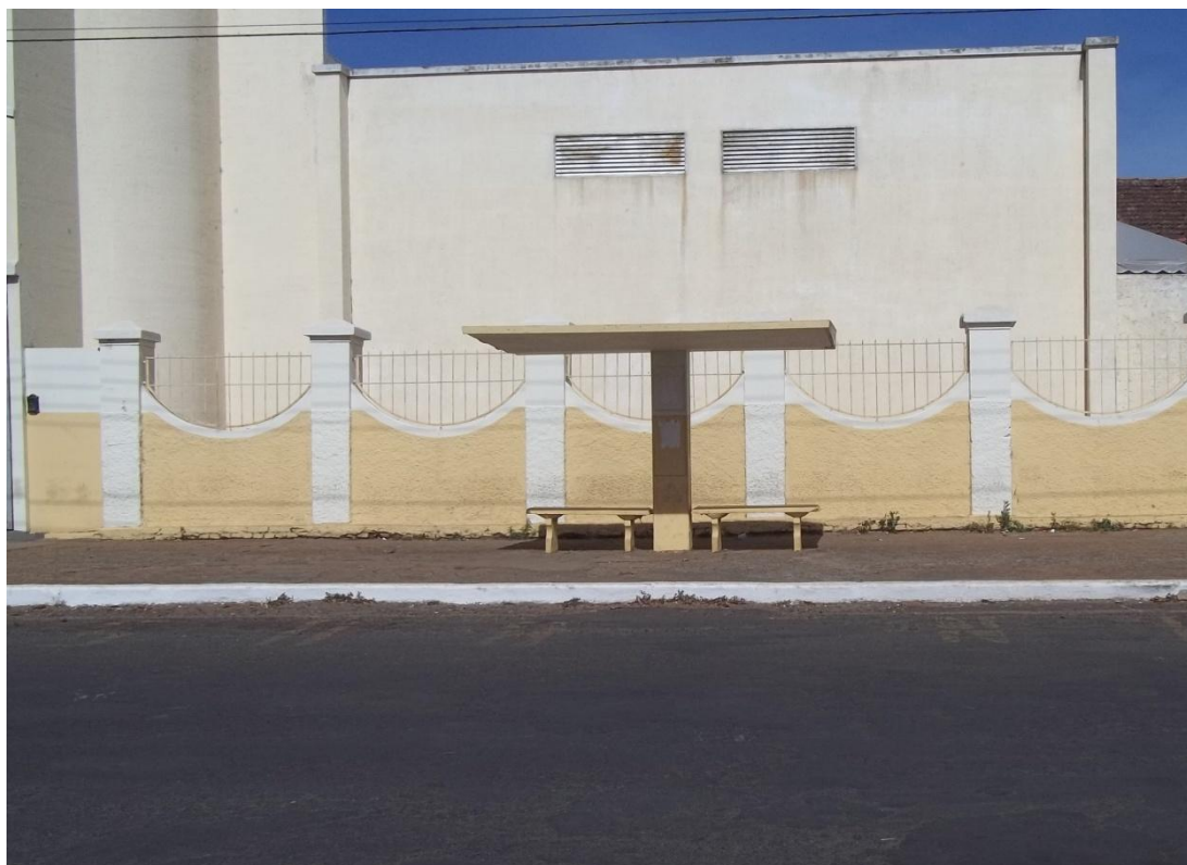
Foto 07: estrutura de concreto ponto de ônibus avenida Minas Gerais – Araguari/2012
