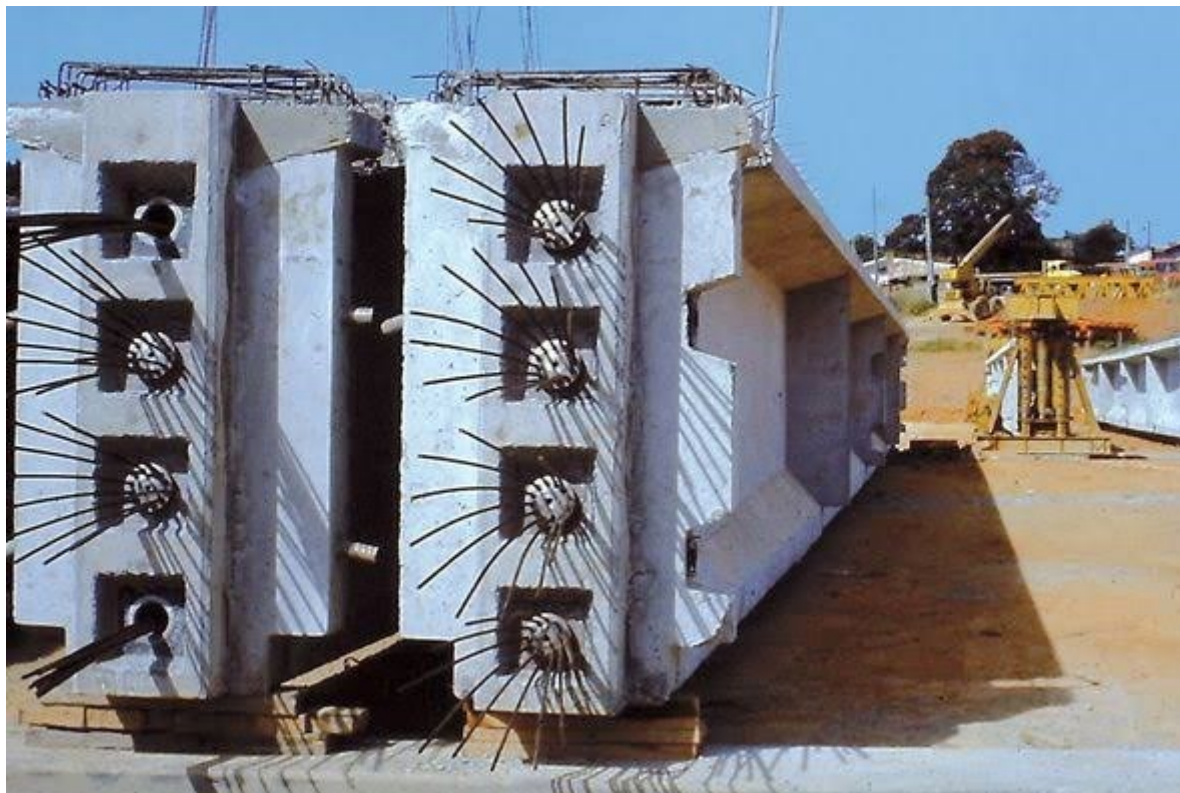
Figura 2 - Ancoragem da armadura de uma viga protendida
