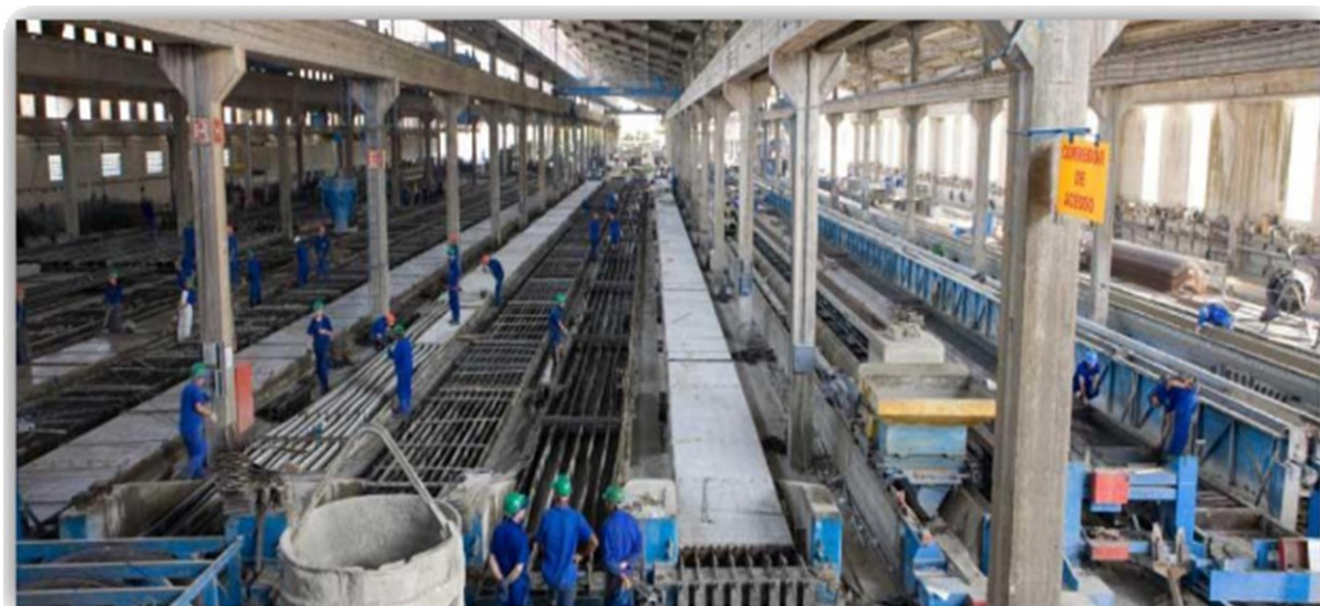
Figura 1 - Pista de protensão
