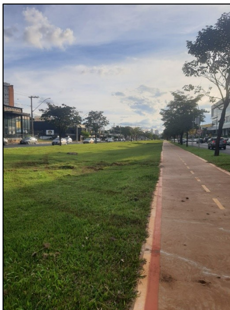
Figura 14 - Avenida Anselmo A. Santos - Trincheiras de infiltração
