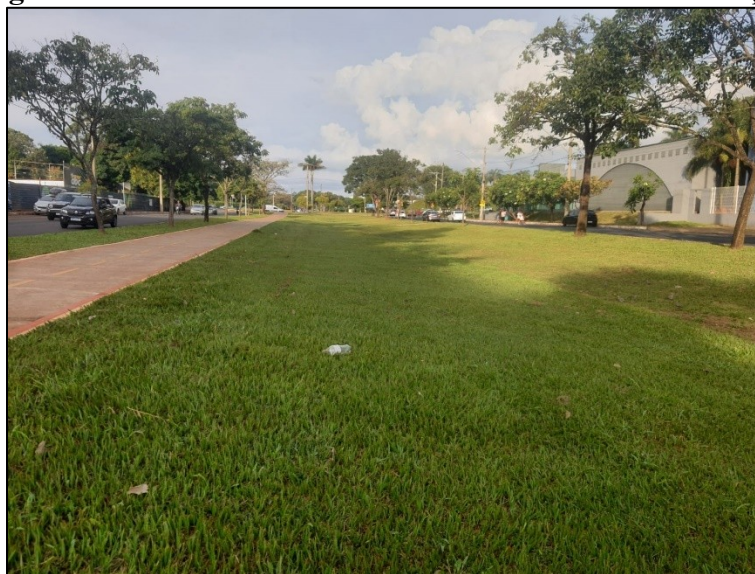
Figura 15 - Av. Anselmo A. Santos - Trincheiras de infiltração
