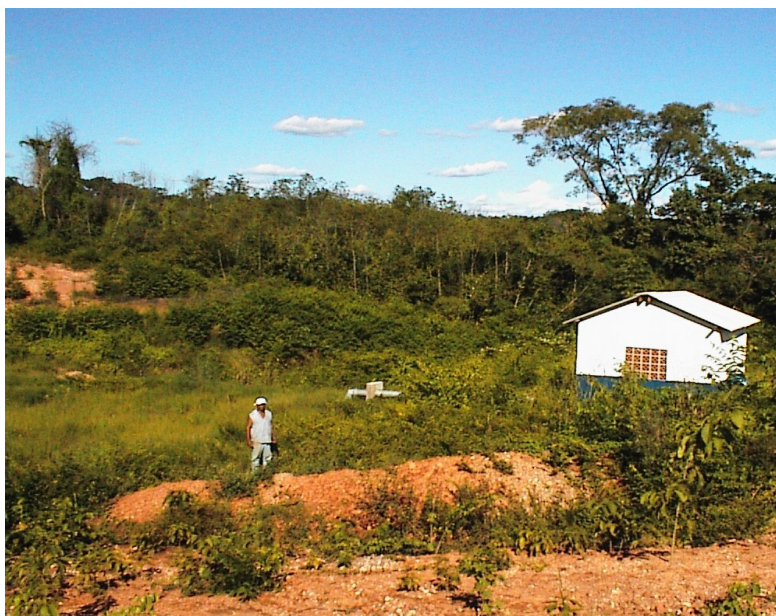
Figura IV.13 – Casa de Bombas de Captação D'água.
