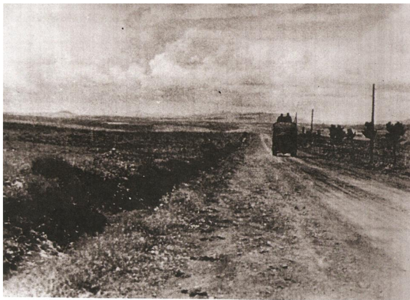
Figura 3 – Camión de montaje
