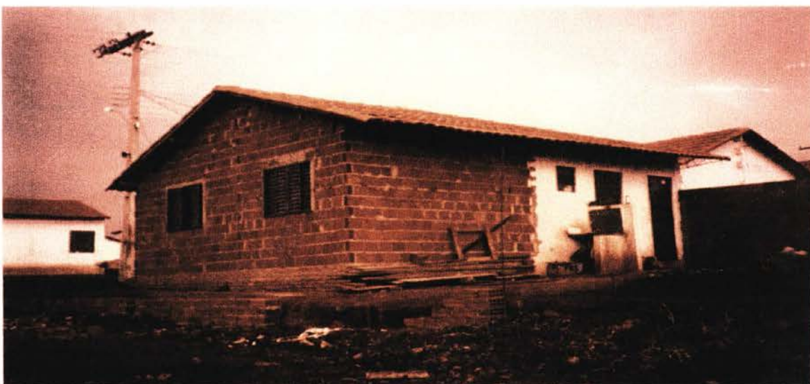
Foto 01: casa modificada para aumentar o espaço interno de uso doméstico. O muro está em construção para proteger o "patrimônio" dos moradores da violência crescente. Autor: Fernando Luiz A. Sobrinho. Julho/94
