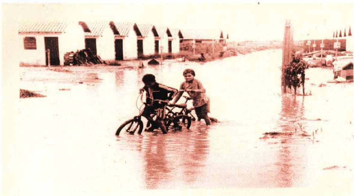
Foto 5- via alagada devido à falta de rede de escoamento pluvial em algumas ruas. Período de chuvas.
